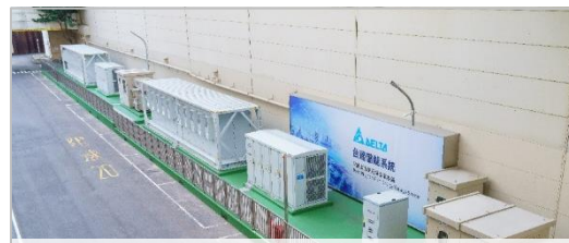
台達桃園平鎮廠 Delta Pingjhen Plant
