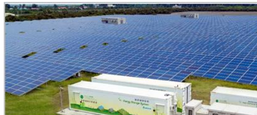
高雄永安太陽光電廠 Taipower Yongan Solar Power Plant
